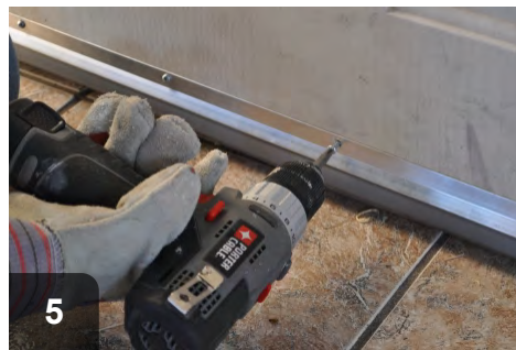
5 Install new door sweep
